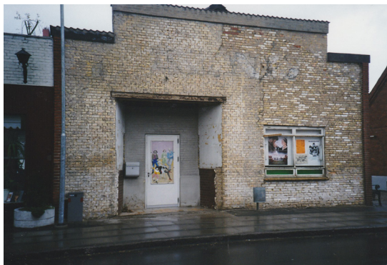
På dette billede af den "nøgne" væg ses tydeligt i murstenene, hvor stor en udvidelse af biografen der var tale om i 1942.
