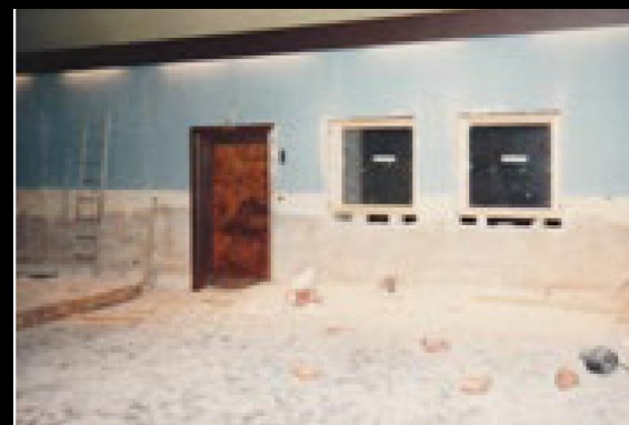
3 nye vinduer i dagcenterdelen samt 2 nye udgangsdøre den ene med handicap-rampe.
